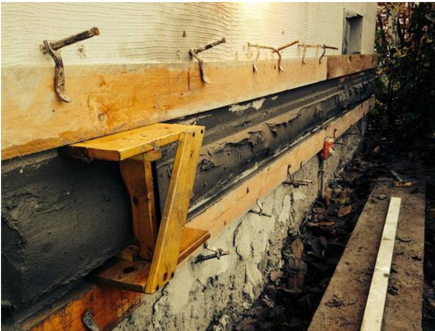
Stuckarbeiten am Sockel des Hauses. Foto: Heitschötter Stuckateur
