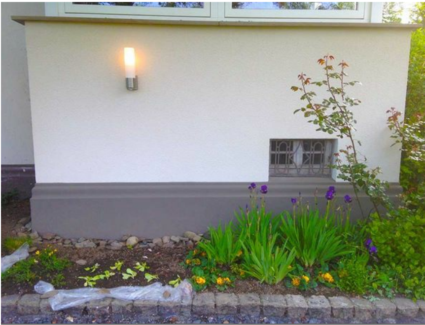
Gelungene Fassadensanierung mit weißem Oberputz und grauem Sockel. Foto: Heitschötter Stuckateur
